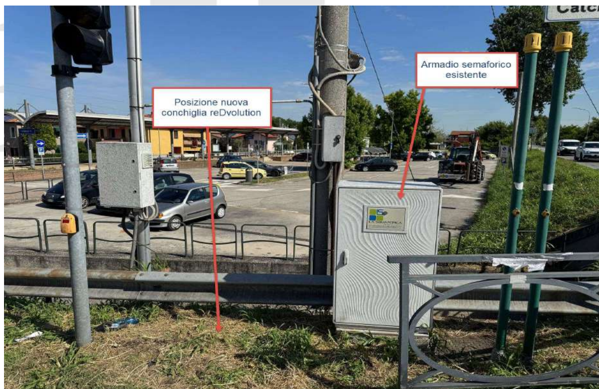
Conchiglia semaforica esistente e posizione nuovo armadio reDvolution
