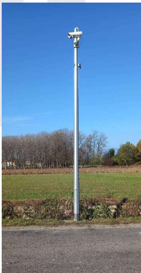
Esempio di installazione tipo telecamera reDvolution su struttura in acciaio a sicurezza passiva
