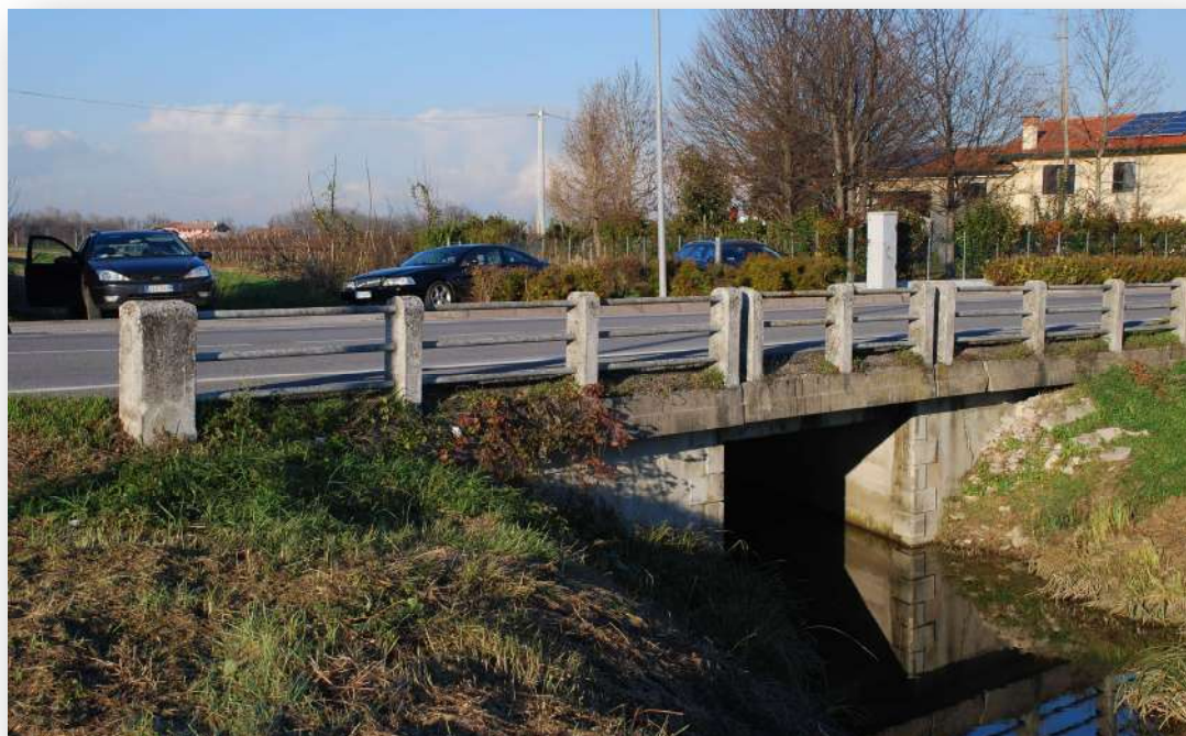
Particolare prospetto a valle del manufatto
