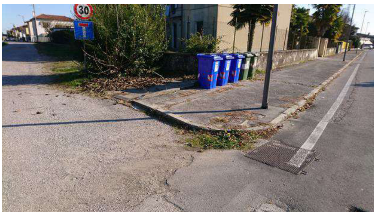
Foto 6 - Barriera architettonica - mancanza di rampa in prossimità di via Alfieri.
