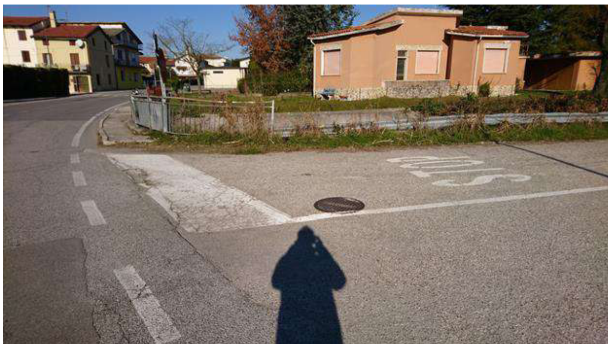
Foto 7 - Barriere architettoniche - superamento canale La Vecchia.
