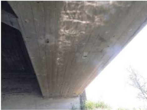
**Foto 10:** in punti sparsi dell'intradosso delle travi a cassone sono presenti macchie di umidità.
