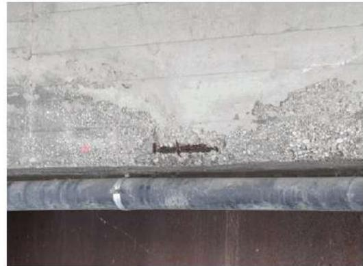
**Foto 22:** in alcuni punti sparsi dei traversi di testata vi è distacco del copriferro.
