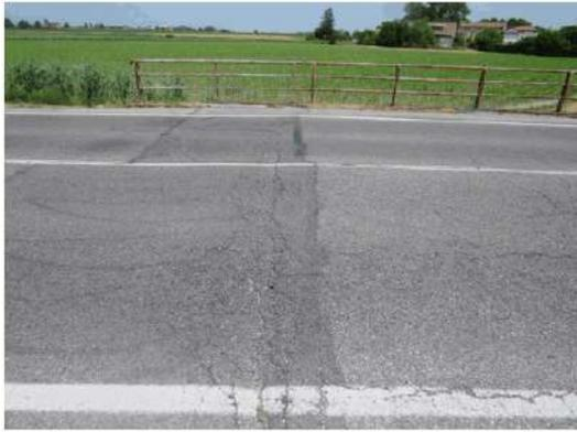
**Foto 8:** *in corrispondenza dei giunti sulle spalle, il tampono è deformato.*
