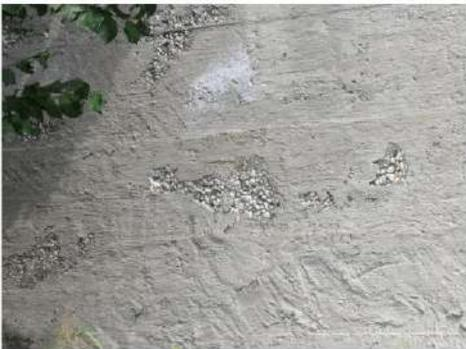
**Foto 3:** sulle facciate laterali di entrambe le spalle si riscontrano vespai con inerti in vista.
