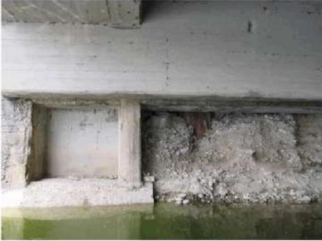
**Foto 1:** alla base e sui pilastri di entrambe le spalle si riscontrano macchie di umidità.
