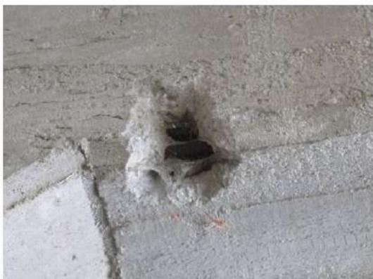
**Foto 18:** ove presente distacco del copriferro sui traversi di campata, l'armatura risulta ossidata.
