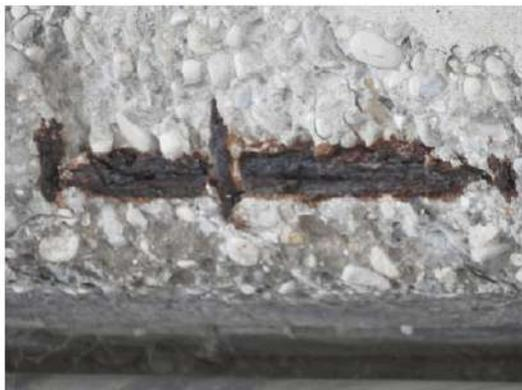
**Foto 23:** ove presente distacco del copriferro sui traversi di testata, l'armatura è corrosa con riduzione di sezione resistente.
