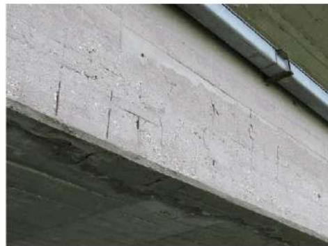
**Foto 15:** in punti sparsi di entrambe le travi longitudinali, soprattutto verso gli appoggi sulle spalle e sulla facciata sinistra della trave sinistra, le staffe sono scoperte e corrose con sezione resistente intaccata.
