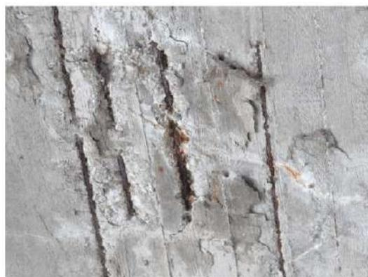
**Foto 31:** ove presente distacco all'intradosso della soletta, le armature affioranti risultano corrose con sezione resistente ridotta.
