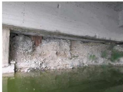
**Foto 6:** in corrispondenza della spalla di monte, il rilevato risulta completamente dilavato.
