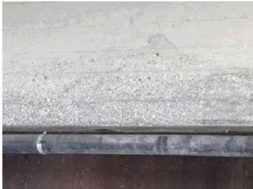
**Foto 21:** in punti sparsi verso la base dei traversi di testata sono presenti vespai con inerti in vista.
