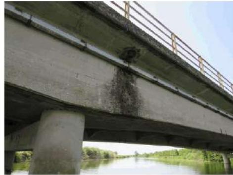
**Foto 11:** sulle facciate esterne di entrambe le travi longitudinali, in corrispondenza degli appoggi e degli scarichi, il calcestruzzo si presenta dilavato.
