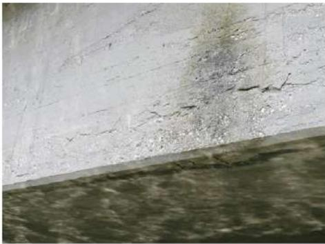
**Foto 12:** su buona parte della superficie di entrambe le travi longitudinali si presentano vespai con inerti in vista.
