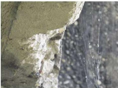
**Foto 14:** ove presente distacco del copriferro sulle travi a cassone, le armature affioranti sono corrose con riduzione di sezione resistente.
