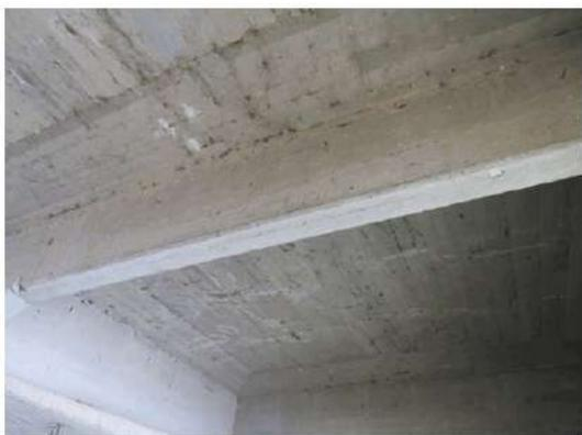
**Foto 16:** in punti sparsi di tutti i traversi di campata si rilevano delle macchie di umidità.
