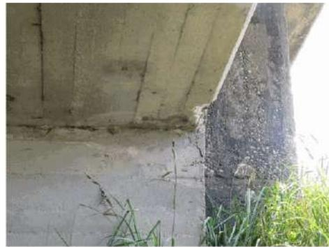
**Foto 13:** all'intradosso delle travi a cassone, specialmente verso gli appoggi sulle spalle, vi è distacco del copriferro.
