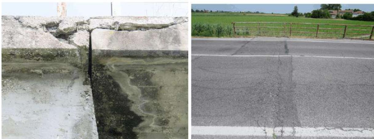
FIGURA 19-2: MANCANZA DI SCOSSALINA SU GIUNTI E TAMPONE SU STRATO DI USURA DEFORMATO
