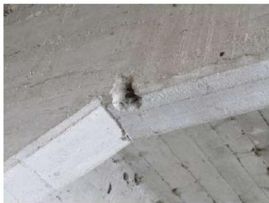
**Foto 17:** in piccoli punti sparsi degli spigoli dei traversi di campata vi è distacco del copriferro.
