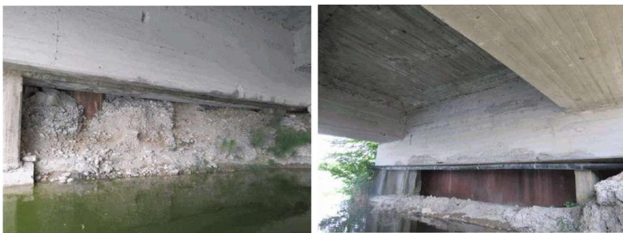
FIGURA 19-6: RILEVATO SU SPALLE COMPLETAMENTE DILAVATO
