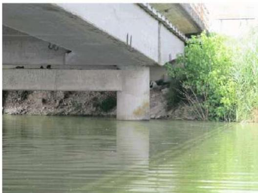
*Foto 7: sui pilastri delle pile sono presenti macchie di umidità.*
