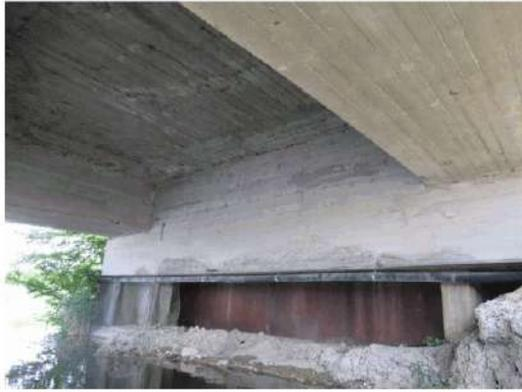
**Foto 19:** alla base di tutti i traversi di testata, specialmente sul traverso di valle, si notano macchie di umidità.
