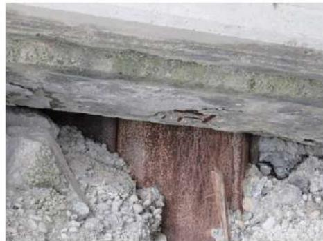
**Foto 4:** all'intradosso dei pulvini delle spalle, specialmente di quella di monte, ed in alcuni punti verso i bordi delle stesse, vi è distacco del copriferro.
