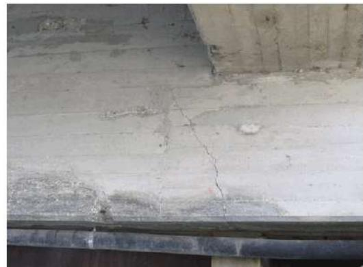
**Foto 24:** il traverso di testata sulla spalla di valle presenta due fessure diagonali a tutta altezza, poste rispettivamente sotto le due travi a cassone ed orientate dall'interno verso l'esterno.
