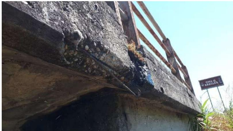
FIGURA 3-5: AMMALORAMENTI DIFFUSI DEGLI ELEMENTI IN CALCESTRUZZO
