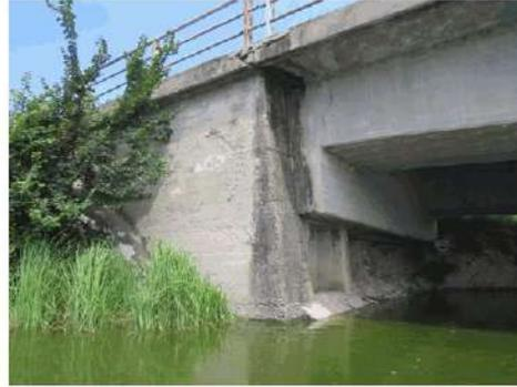
**Foto 2:** su tutta la superficie delle spalle, specialmente ai bordi, il calcestruzzo risulta dilavato.
