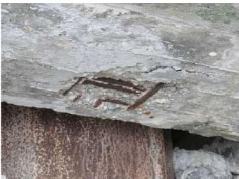
**Foto 5:** ove presente distacco del copriferro sulle spalle, le armature affioranti si presentano corrose con riduzione di sezione resistente.
