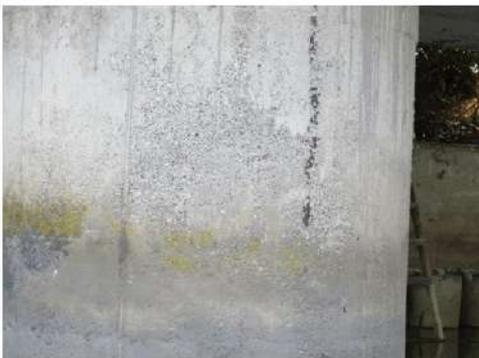
**Foto 6:** in ampie zone sui pilastri delle pile si riscontrano vespai superficiali.
