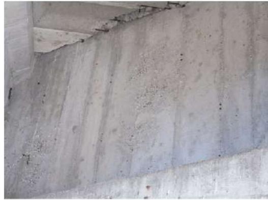
**Foto 19:** in vari punti su tutti i traversi si rilevano vespai con inerti in vista.
