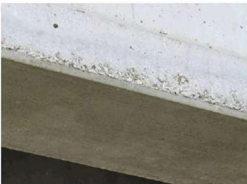
**Foto 15:** in piccoli punti sparsi lungo le travi longitudinali vi sono vespai con inerti in vista.
