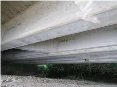
**Foto 13:** all'intradosso e verso gli appoggi delle travi longitudinali vi sono macchie di umidità.
