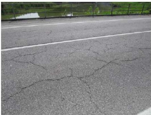
**Foto 23:** su tutta la superficie di entrambe le corsie la pavimentazione presenta fessure.
