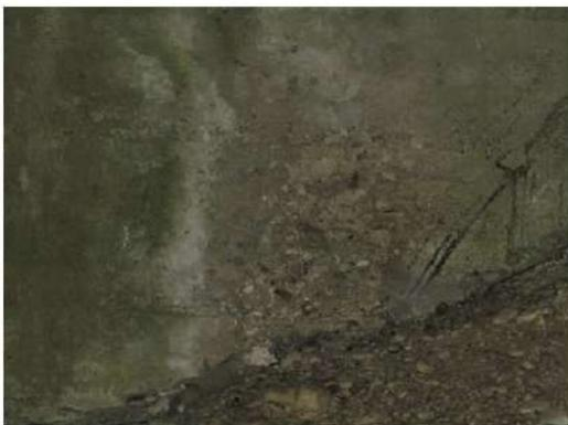
**Foto 3:** *in alcuni punti verso i bordi laterali della spalla di monte si notano vespai con inerti in vista.*
