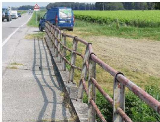
**Foto 24:** sul lato destro della campata centrale, i parapetti risultano danneggiati.
