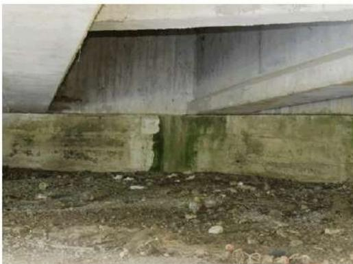
**Foto 1:** *su tutta la superficie di entrambe le spalle, specialmente su quella di monte, si notano macchie di umidità.*
