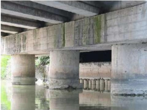
**Foto 4:** su tutta la superficie delle pile vi sono macchie di umidità.
