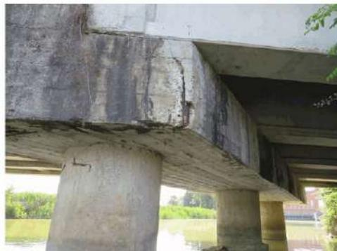
**Foto 7:** in più zone all'intradosso dei pulvini delle pile e sugli spigoli degli stessi vi è distacco del copriferro.
