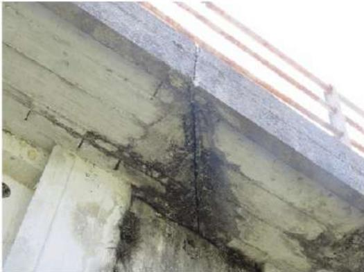
**Foto 12:** in corrispondenza di tutti i giunti è assente la scossalina con conseguente dilavamento delle strutture sottostanti.
