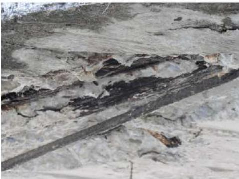
**Foto 8:** ove presente distacco del copriferro sui pulvini, le armature affioranti risultano corrose con sezione resistente ridotta.
