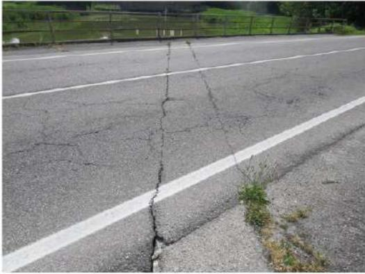
**Foto 10:** in corrispondenza di entrambe le pile, i giunti manifestano deformazione del tampone con presenza di fessurazioni evidenti sulla pavimentazione.
