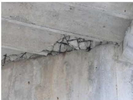
**Foto 22:** in tutte le zone di connessione con travi e traversi la soletta è rotta.
