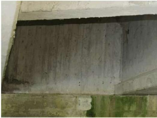
**Foto 18:** sui traversi, soprattutto su quelli di testata, vi sono macchie di umidità.
