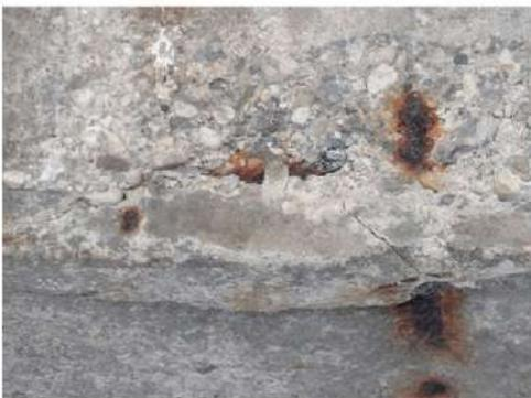
**Foto 17:** ove presente distacco del copriferro lungo le travi, le armature affioranti sono corrose con sezione resistente intaccata.
