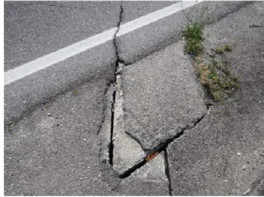
**Foto 11:** particolare dei giunti deformati sulle pile, in cui si possono apprezzare le fessurazioni sulla pavimentazione e la discontinuità tra gli elementi strutturali.
