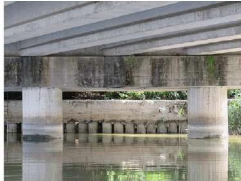
**Foto 5:** ovunque sul pulvino di entrambe le pile il calcestruzzo risulta dilavato.
