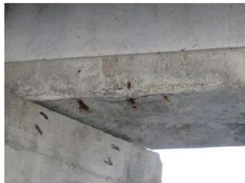
**Foto 16:** all'intradosso delle travi longitudinali, in rare zone verso gli appoggi, vi è distacco del copriferro.
