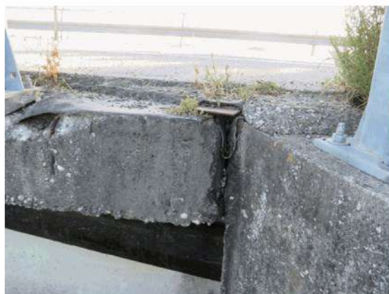
FIGURA 18-2: AMMALORAMENTO DEL GIUNTO DILATAZIONE CON SCHIACCIAMENTO DELLE SCOSSALINE
