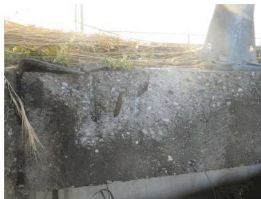
FIGURA 18-4: DILAVAMENTO DELLE FACCIATE CON OSSIDAZIONE ARMATURE
