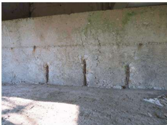
FIGURA 18-1: ESPOSIZIONE DELLE STAFFE ALLA CORROSIONE PER PREGRESSA ESPULSIONE COPRIFERRO
