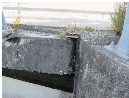
Foto 8: le scossaline di entrambe i giunti risultano schiacciate.
