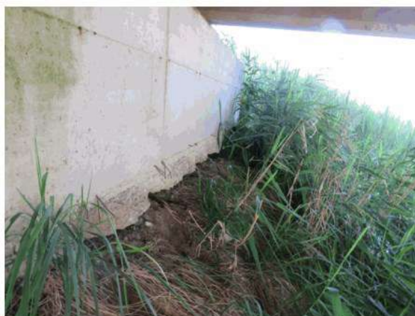
FIGURA 18-3: SCALZAMENTO DELLE SPALLE
