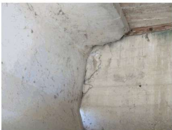
FIGURA 18-5: DANNEGGIAMENTO MURO PARAGHIAIA ED ESPOSIZIONI FERRI DI ARMATURA TRAVATE
