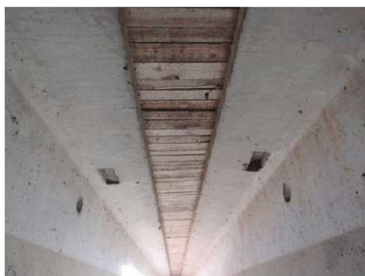
Foto 17: la soletta tra le travi è rivestita da assi in legno.
