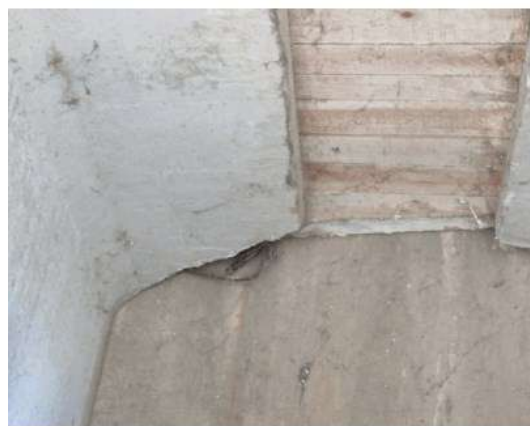
FIGURA 18-5: DANNEGGIAMENTO MURO PARAGHIAIA ED ESPOSIZIONI FERRI DI ARMATURA TRAVATE
