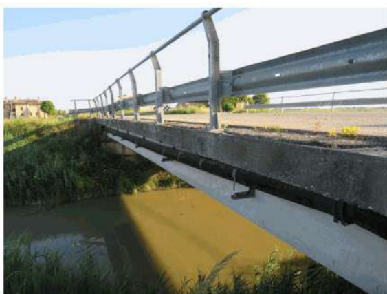
FIGURA 18-4: DILAVAMENTO DELLE FACCIATE CON OSSIDAZIONE ARMATURE
