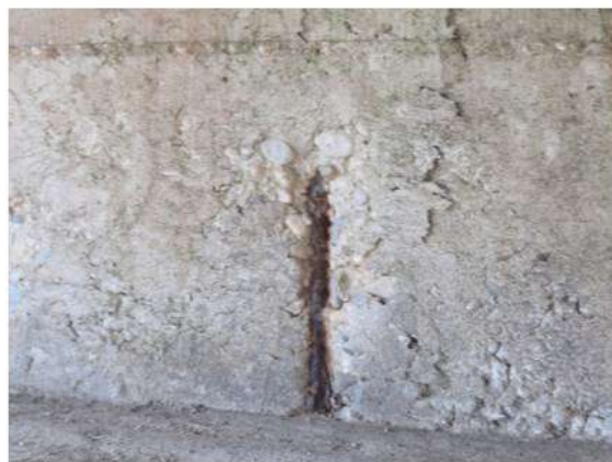
FIGURA 18-1: ESPOSIZIONE DELLE STAFFE ALLA CORROSIONE PER PREGRESSA ESPULSIONE COPRIFERRO
