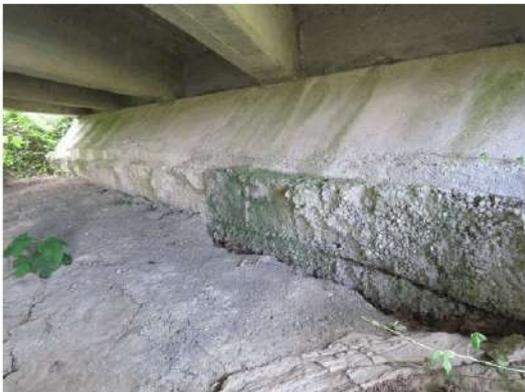
**Foto 3:** tutta la base della spalla di valle è ammalorata.
