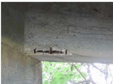
**Foto 14:** in diversi punti sugli spigoli delle travi il calcestruzzo è in fase di distacco, mentre in due zone sugli spigoli della trave di bordo sinistra su I e III campata da monte il copriferro è già distaccato.
