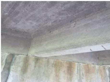
**Foto 12:** in alcune zone sulle travi, specialmente verso gli appoggi, si notano delle macchie di umidità.
