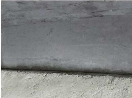
**Foto 18:** in alcune zone alla base dei traversi di testata sono visibili delle macchie di umidità.
