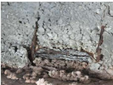
**Foto 20:** ove presente distacco del copriferro sul traverso di testata sulla spalla di monte, l'armatura affiorante è corrosa con sezione resistente ridotta.
