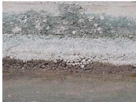
**Foto 8:** in pochi punti sulle pile, specialmente alla base ove presenti umidità e dilavamento più intensi, si osservano dei vespai con inerti in vista.
