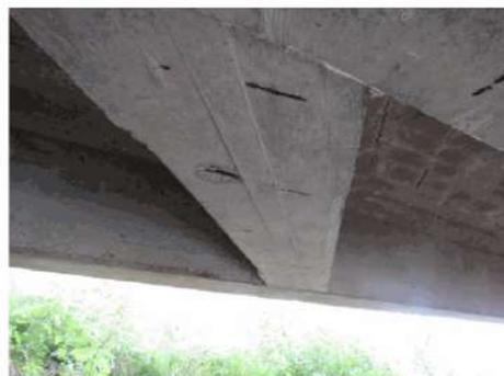
**Foto 21:** in alcune zone all'intradosso dei traversi di campata si notano staffe scoperte e corrose con sezione resistente intaccata.
