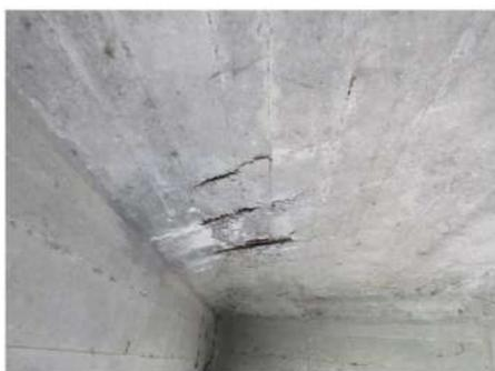
**Foto 24:** in alcune zone sparse all'intradosso delle solette tra le travi si osserva il distacco del copriferro.
