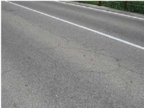
**Foto 26:** su tutta la pavimentazione si notano fessure ed anomalie sparse.
