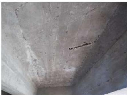
**Foto 22:** in ampie zone all'intradosso delle solette sono presenti macchie di umidità.
