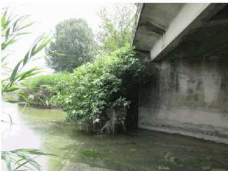
**Foto 9:** davanti allo spigolo sinistro della pila di valle si segnala la presenza di un grosso arbusto.
