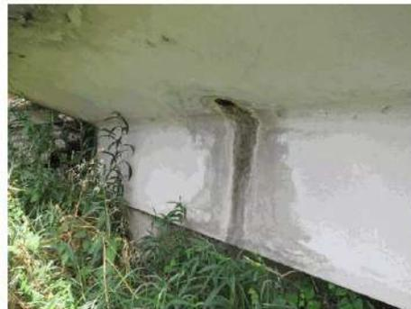
**Foto 13:** sulle facciate laterali delle travi di bordo in corrispondenza degli scarichi corti e dei giunti il calcestruzzo si mostra dilavato.
