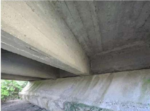
**Foto 1:** su tutta la superficie della spalla di valle e su buona parte di quella di monte sono visibili macchie di umidità.
