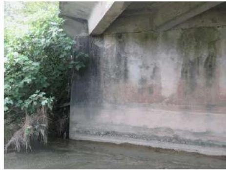
**Foto 6:** tutta la superficie delle pile appare dilavata.
