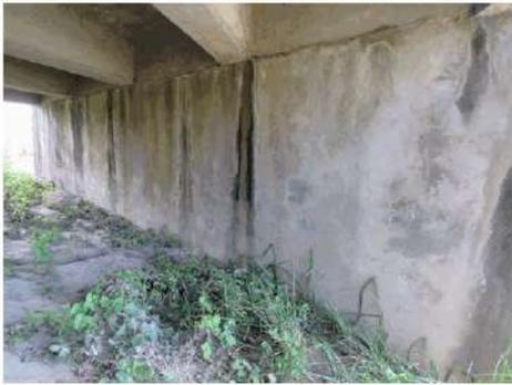
**Foto 5:** ovunque sulle pile si rilevano macchie di umidità.
