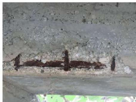
**Foto 15:** sugli spigoli della trave di bordo sinistra su I e III campata da monte dove è avvenuto il distacco del copriferro, l'armatura affiorante risulta corrosa con riduzione della sezione resistente.
