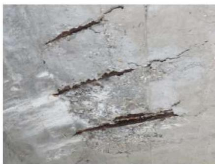
**Foto 25:** ove presente distacco del copriferro all'intradosso delle solette, le armature affioranti sono corrose con sezione resistente ridotta.
