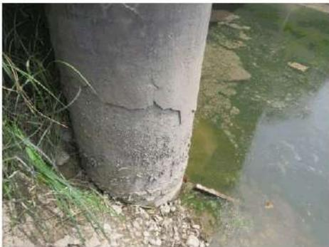
**Foto 7:** in ampie zone delle pile, soprattutto verso la base, il calcestruzzo risulta ammalorato.
