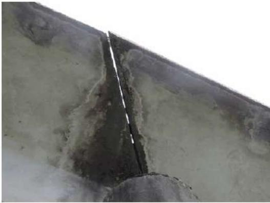
**Foto 11:** sui giunti sulle pile tutte le scossaline sono assenti.
