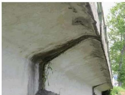
**Foto 23:** sulle solette, sulle facciate laterali e all'intradosso lungo due fasce verso i bordi e in prossimità dei giunti, il calcestruzzo si presenta dilavato.
