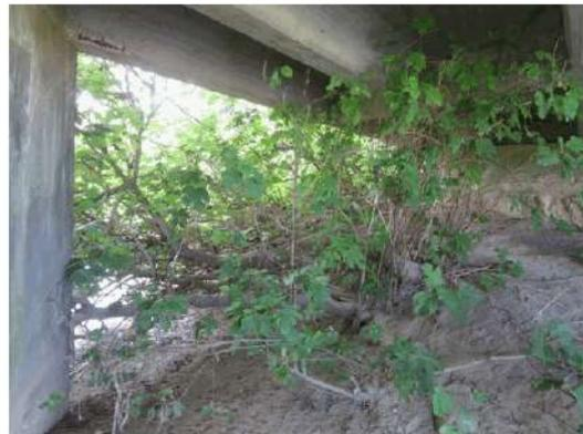
**Foto 4:** tutto il rilevato antistante la spalla di valle si presenta dissestato con crescita di grossi arbusti.
