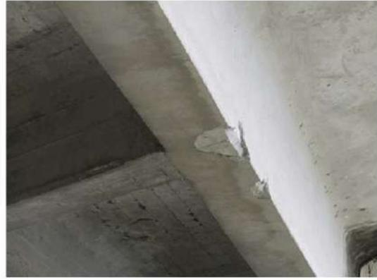
**Foto 17:** tutte le riprese successive sulle travi della campata centrale sono deteriorate.
