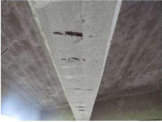
**Foto 16:** all'intradosso delle travi della I campata da monte si osservano staffe scoperte e corrose con riduzione della sezione resistente.
