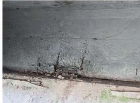
**Foto 19:** in un punto sul traverso di testata sulla spalla di monte si riscontra il distacco del copriferro.
