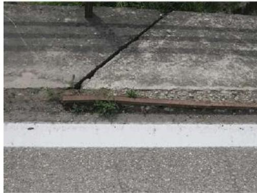
**Foto 27:** a bordo carreggiata si segnala la presenza di profili in acciaio lungo i bordi dei marciapiedi che risultano piegati e svergolati in alcuni punti, in particolare in corrispondenza della pila di valle sul lato destro.
