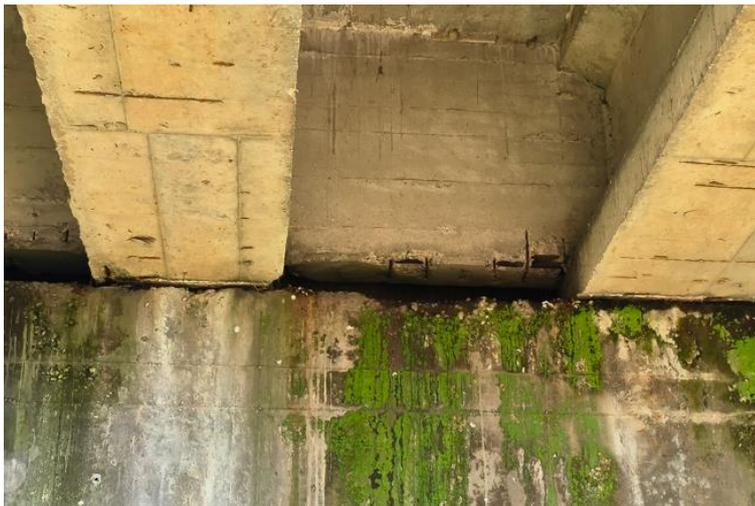
**Figura Errore. Nel documento non esiste testo dello stile specificato.-3 - Distacco di copriferro ed armatura ossidata**
