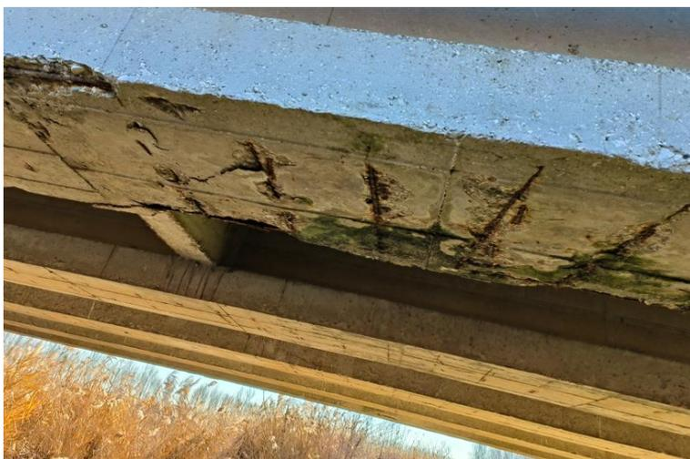
**Figura Errore. Nel documento non esiste testo dello stile specificato.-2 – Dilatamento e distacco di copriferro piattabanda inferiore trave**
