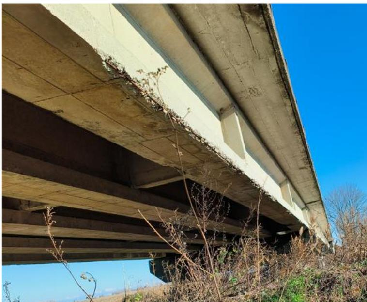
**Figura Errore. Nel documento non esiste testo dello stile specificato.-1 – Distacco di copriferro piattabanda inferiore trave**
