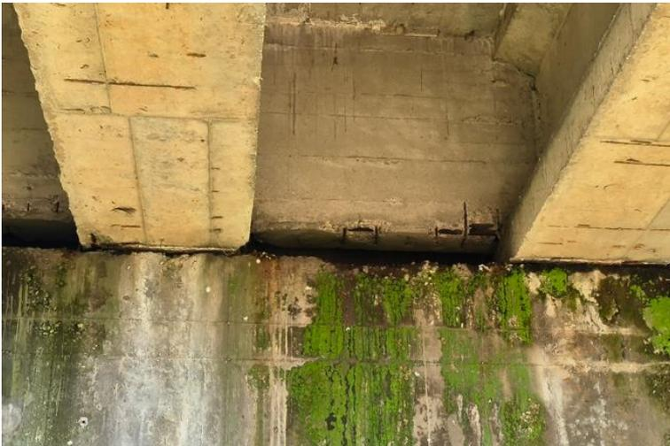
**Figura 11-3 - Distacco di copriferro ed armatura ossidata**
