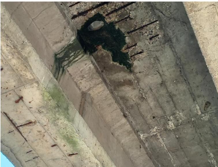
**Figura 11-4 – Calcestruzzo dilavato/ammalorato in soletta con distacco di copriferro ed armatura ossidata in corrispondenza del pluviale**
