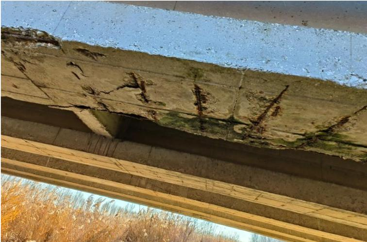
**Figura 11-2 – Dilavamento e distacco di copriferro piattabanda inferiore trave**
