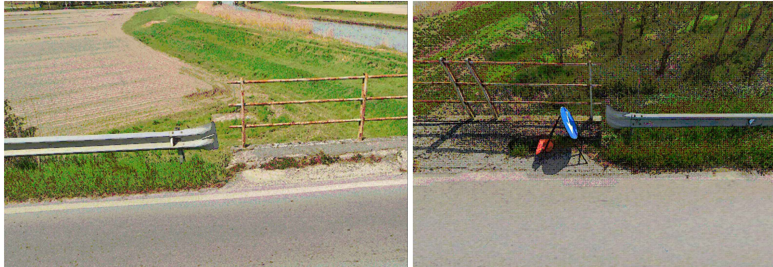
FOTO-01 (DIR. S. STINO DI LIVENZA) NODO DI TRANSIZIONE LATO SINISTRO DA REALIZZARE COME DA PROGETTO
