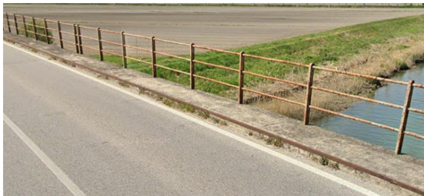
Figura 11 – Barriere di sicurezza e cordoli
