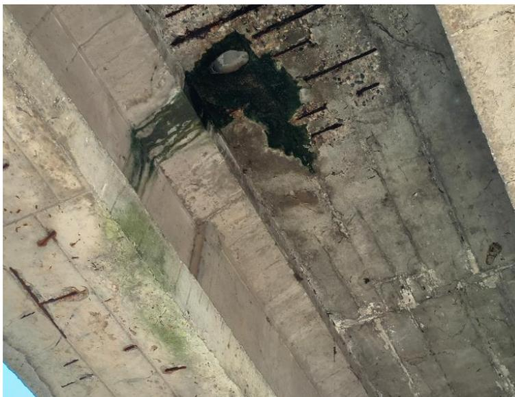
**Figura 3-6 – Calcestruzzo dilavato/ammalorato in soletta con distacco di copriferro ed armatura ossidata in corrispondenza del pluviale**
