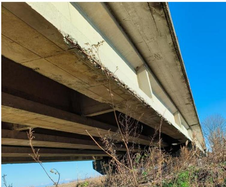
**Figura 3-3 – Distacco di copriferro piattabanda inferiore trave**
