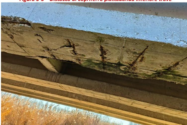
**Figura 3-4 – Dilavamento e distacco di copriferro piattabanda inferiore trave**
