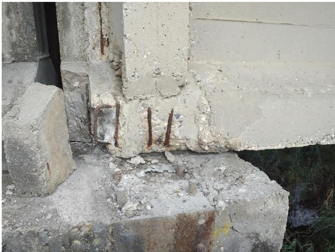
**Figura 10-13 - Appoggi esistenti (probabilmente in piombo)**
