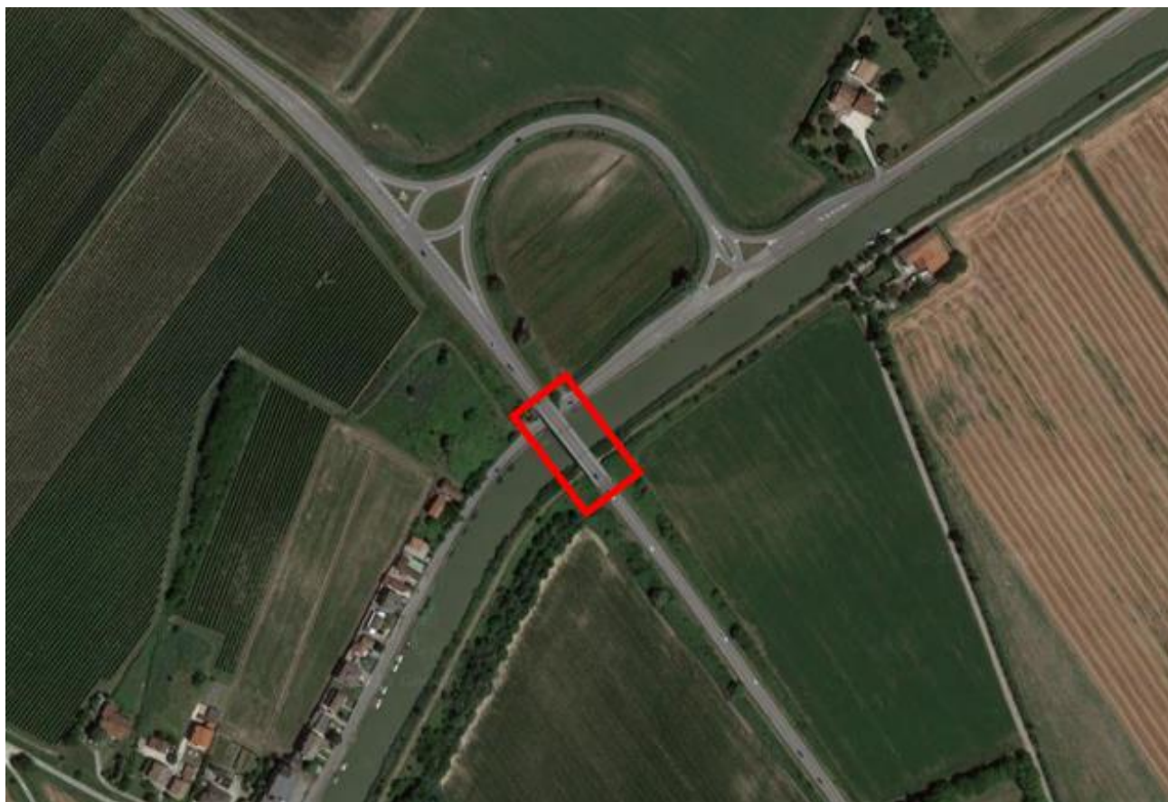
Figura 1 – Localizzazione del manufatto (fonte Google Maps 45°33'22.6"N 12°44'12.4"E)
