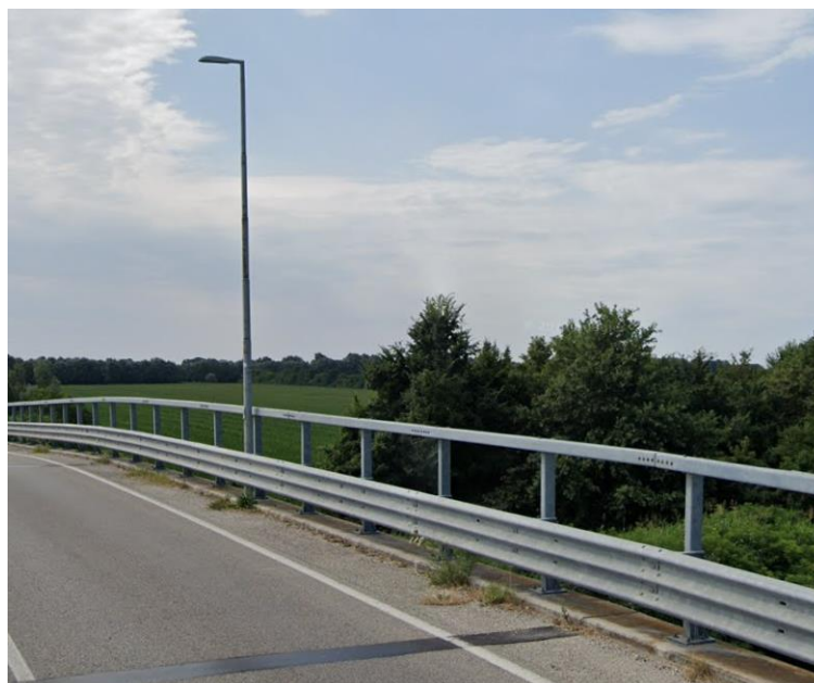
Figura 15 - Giunto a tampone
