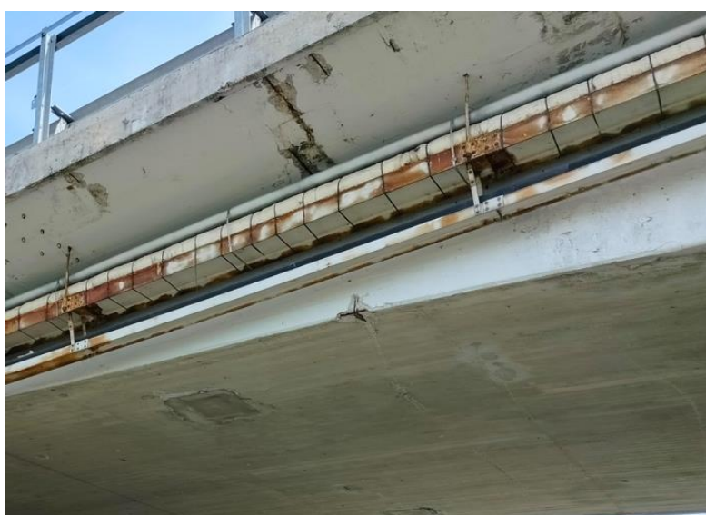
Figura 6 – Prima campata – danno da urto
