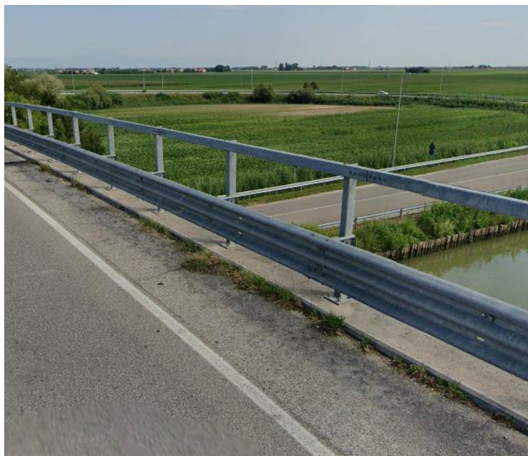
Figura 13 – Barriere di sicurezza e cordoli
