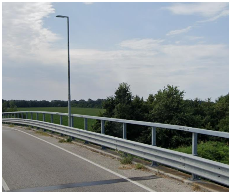
Figura 17 - Giunto a tampone
