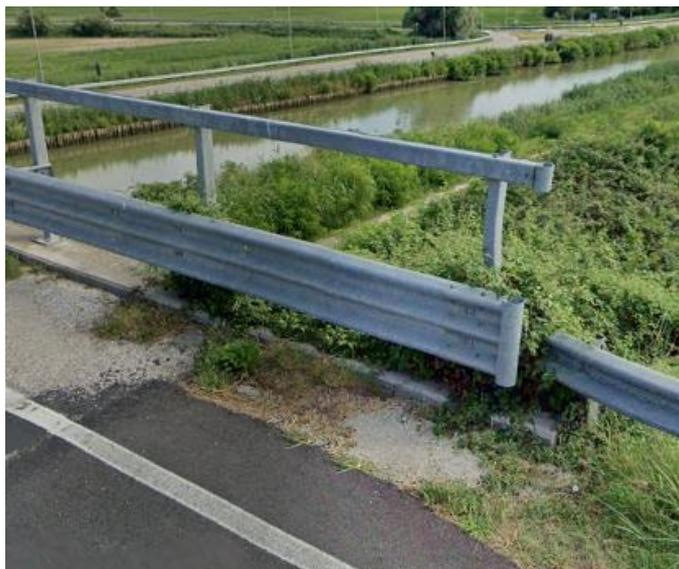
**Figura 86 – Assenza raccordo barriere stradali in corrispondenza Spalla 2**
