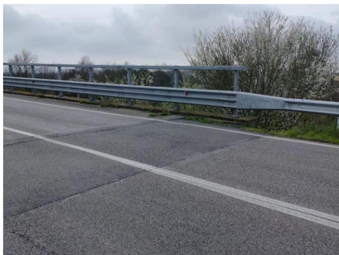
**Figura 87 – Assenza raccordo della bandella superiore della barriera stradale H2BP con il montante della barriera H2BL (corsia direzione Eraclea Mare)**
