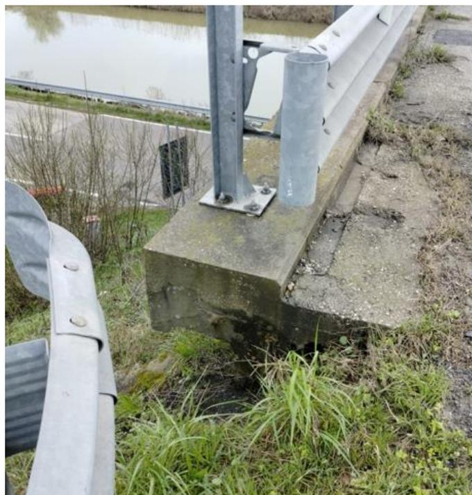
**Figura 85 – Assenza raccordo barriere stradali in corrispondenza Spalla 1**
