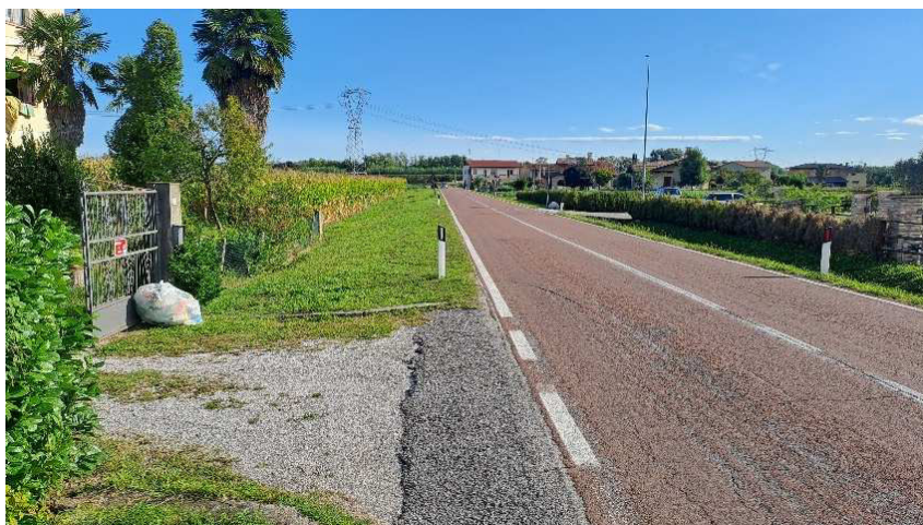
Accessi carraio residenziale
