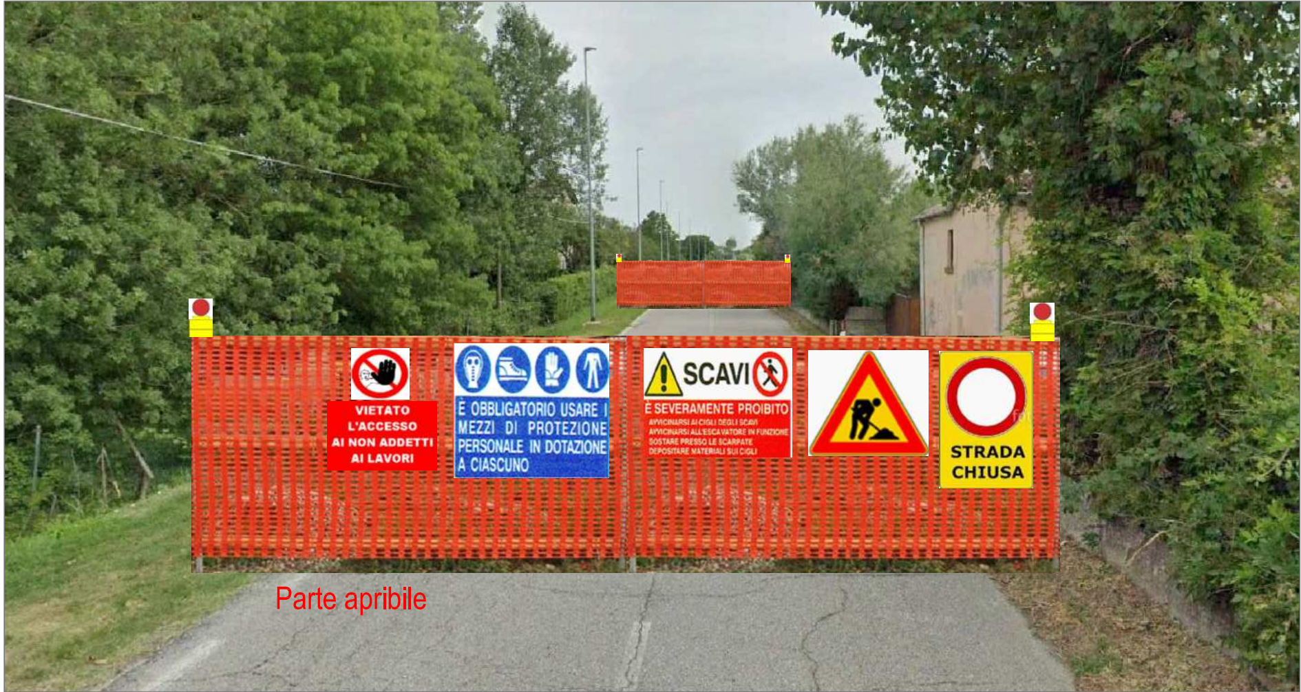
Particolare sbarramento Sud
