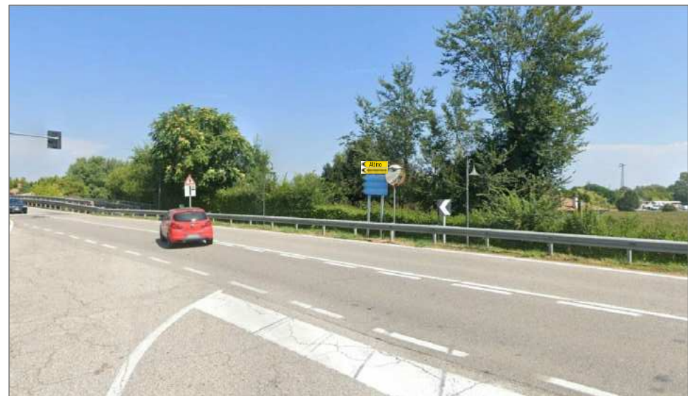
Particolare incrocio Via Trieste > S.S.14 da Ovest
