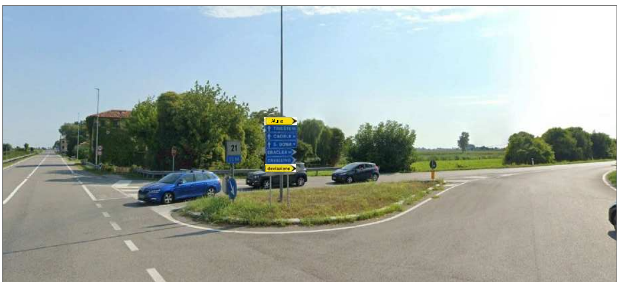
Particolare incrocio S.S.14 > Via Trezze, da Ovest
