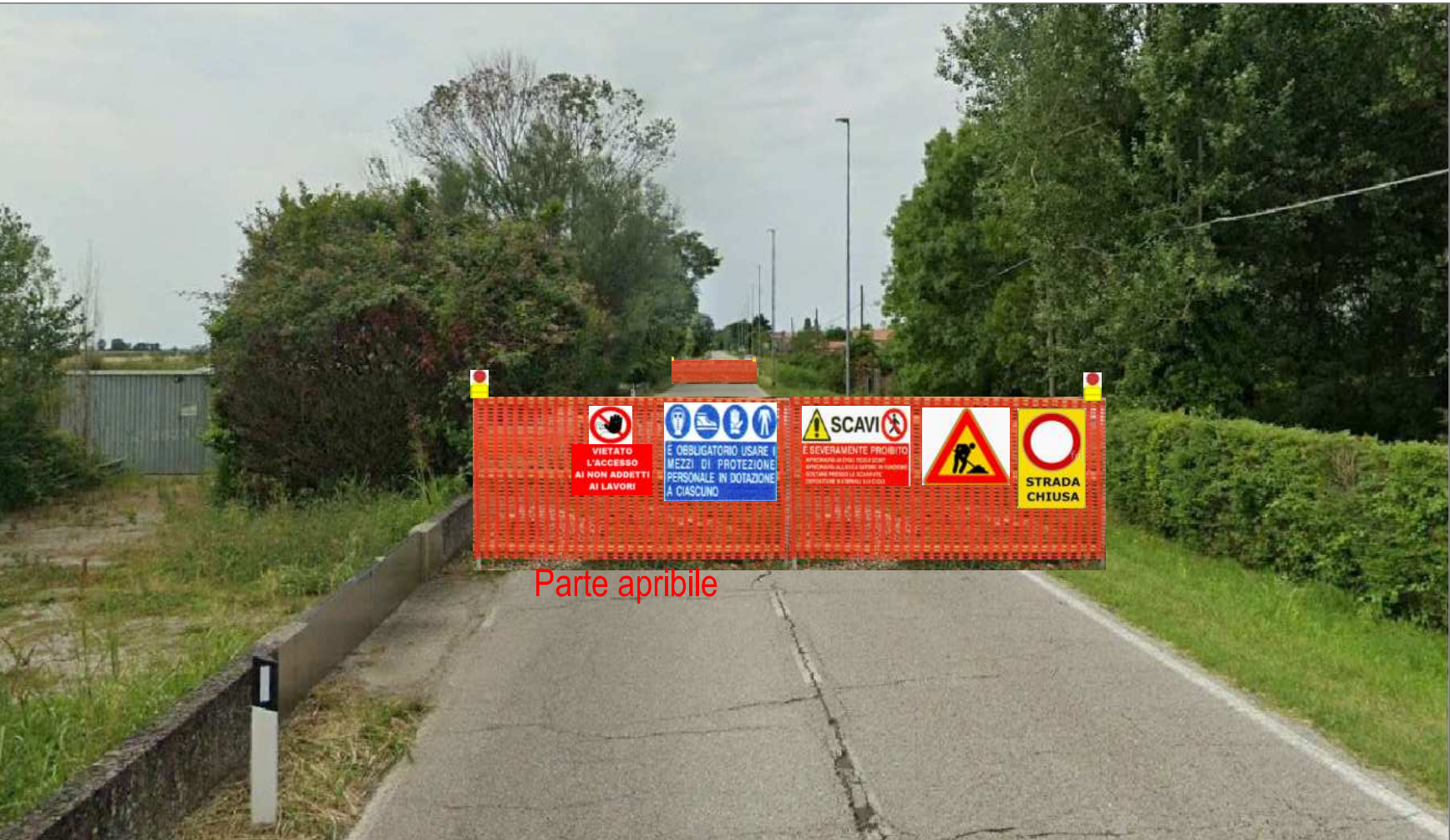
Particolare sbarramento Nord
