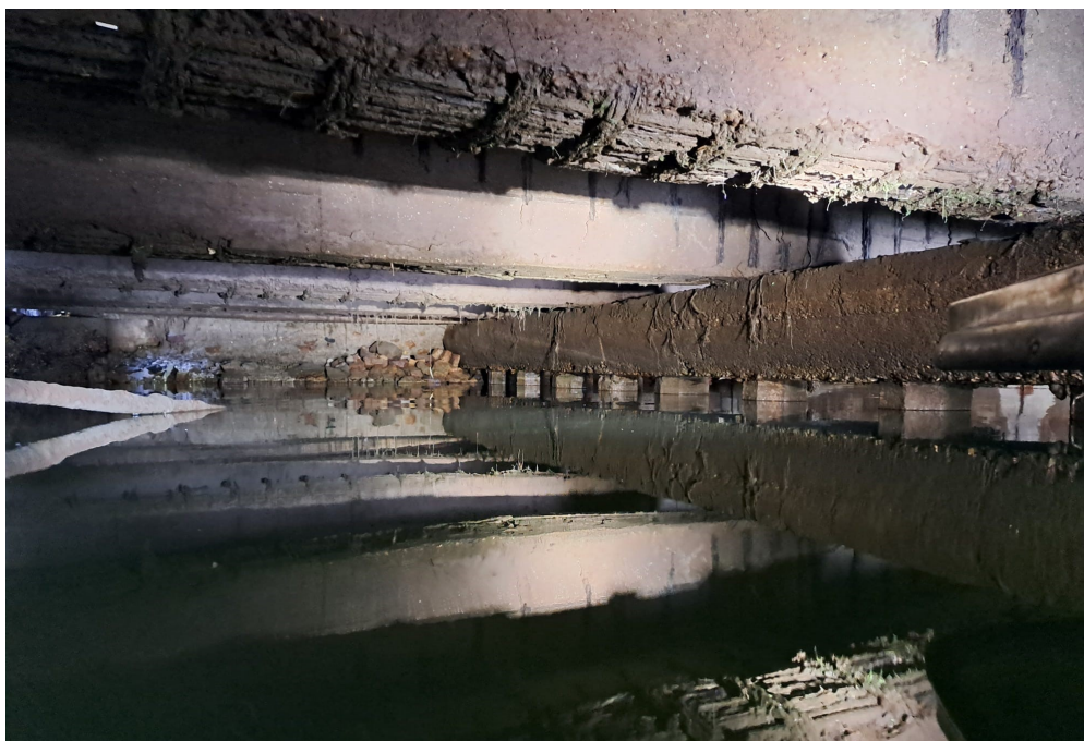
Vista sotto-soletta del manufatto esistente
