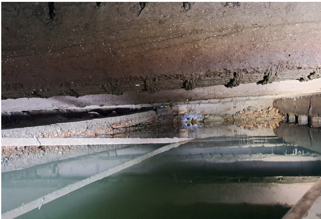
Stato attuale sotto soletta non visibile da alcuna posizione
