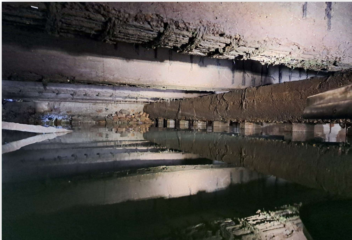
Particolare intradosso impalcato del manufatto
