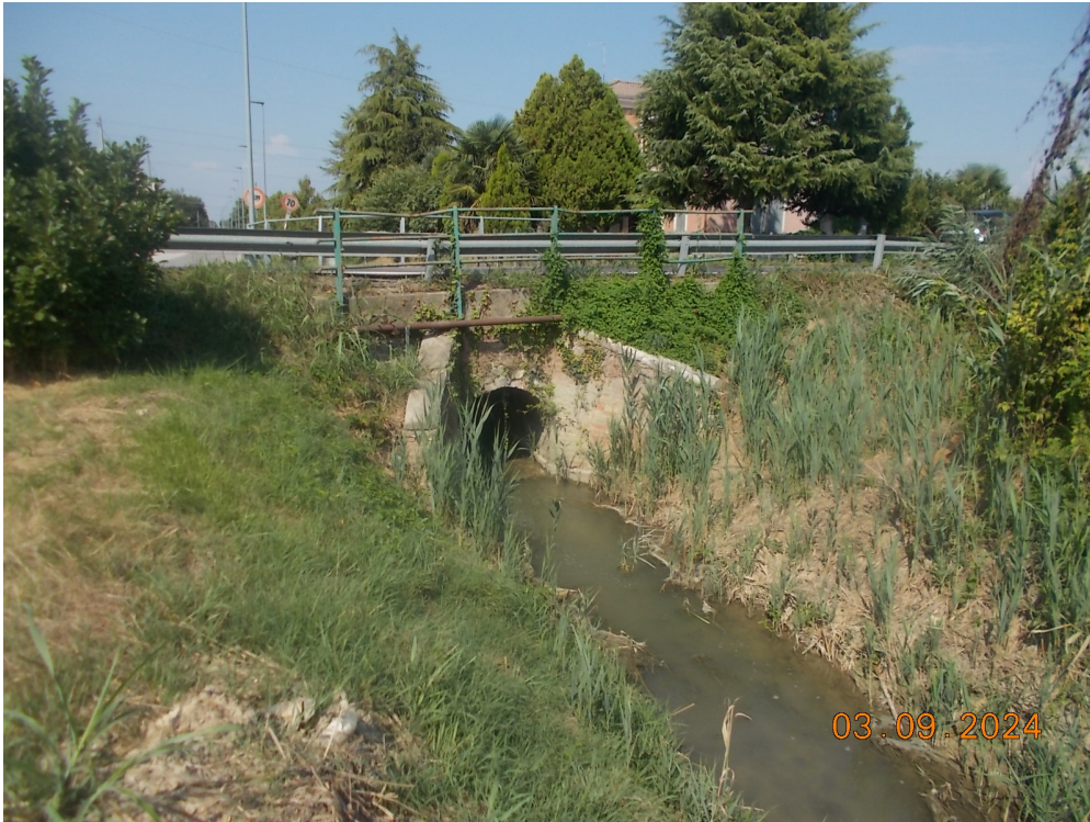
Prospetto a valle del manufatto esistente
