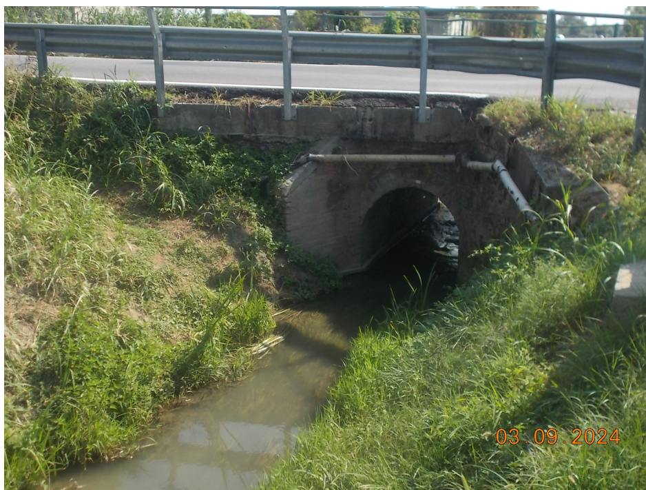
Prospetto a monte del manufatto esistente
