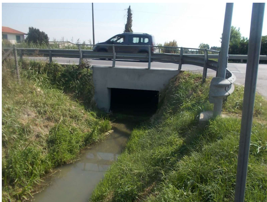
Vista Prospettica a Monte
