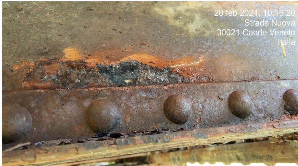
*Fig.30 Ponte di Caorle – effetti della corrosione*
