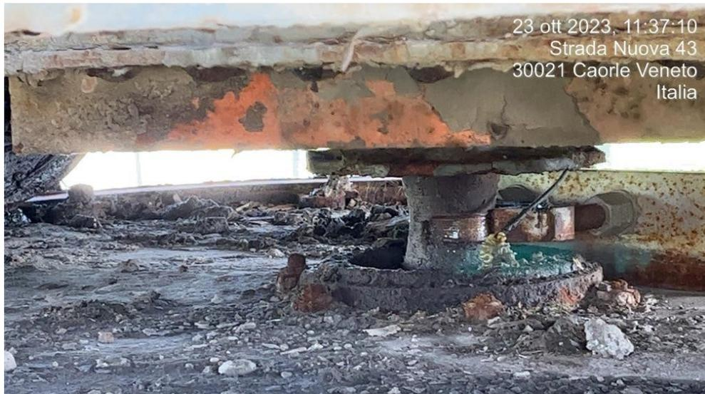
*Fig.26 Ponte di Caorle asse di centraggio con incisione per usura*
