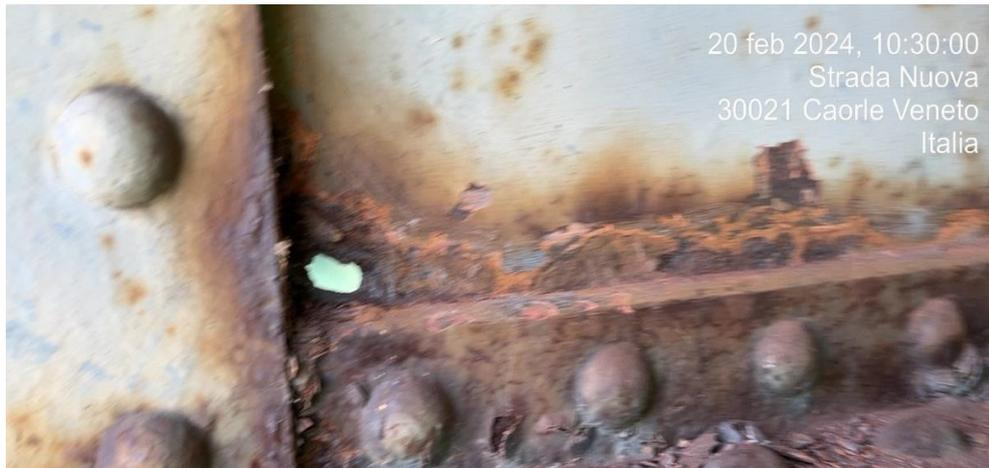
*Fig.33 Ponte di Caorle – effetti della corrosione*
