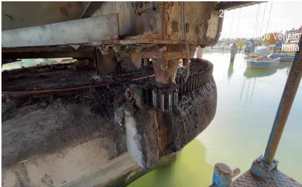
Fig.22 Ponte di Caorle meccanismo di rotazione
