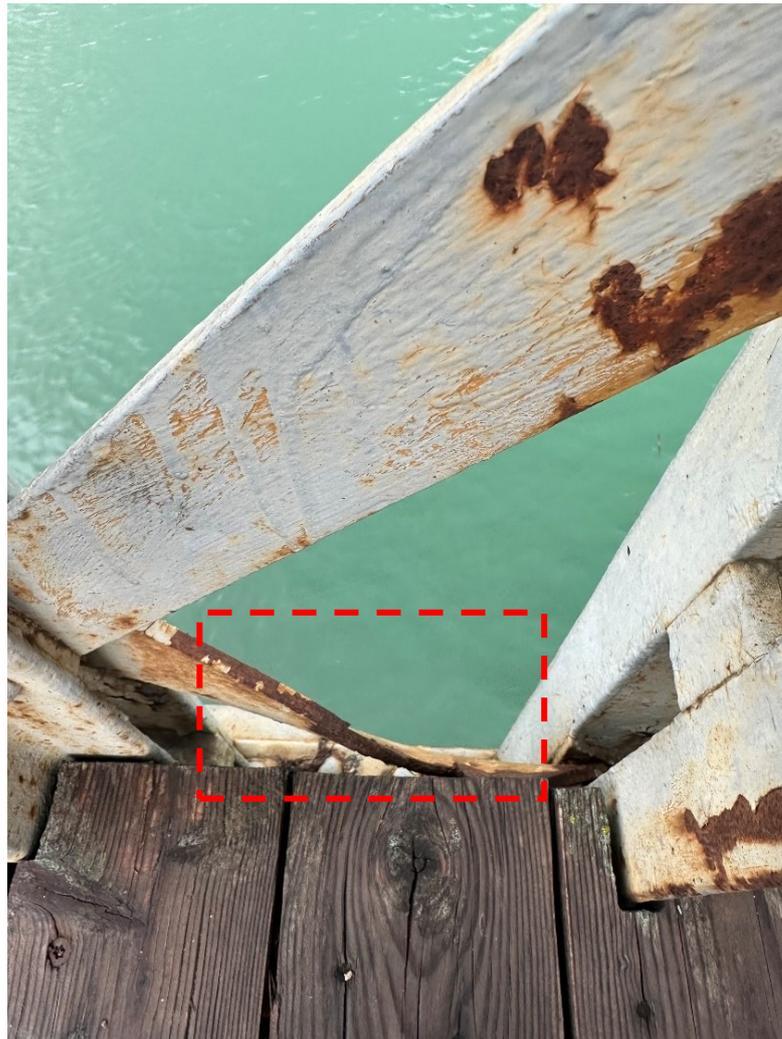
*Figura 14: Diagonale con sezione corrosa e ridotta*
