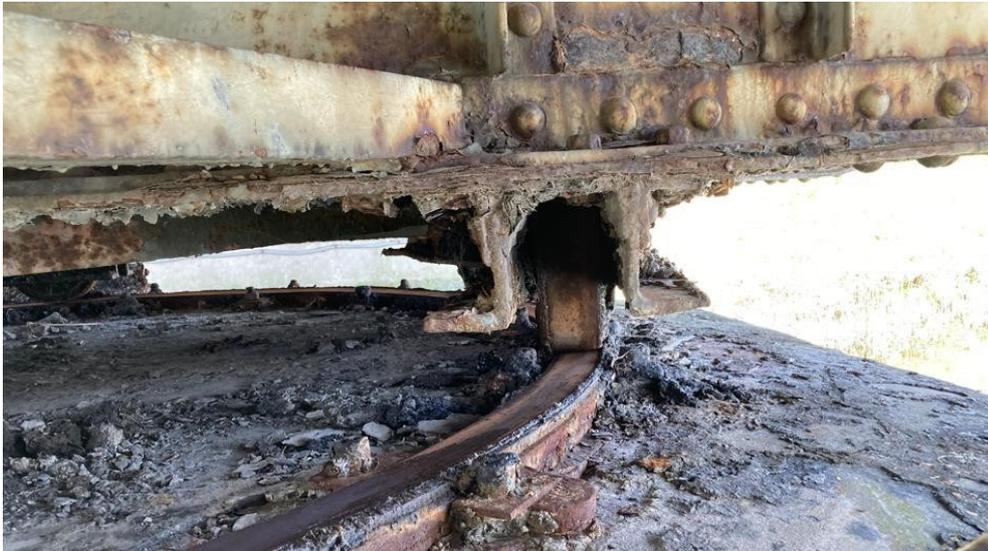
Fig.29 Ponte di Caorle gruppo rulliera – dettaglio degrado strutturale
