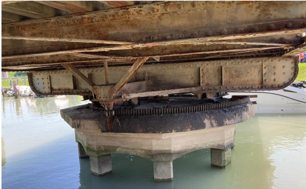
Fig.24 Ponte di Caorle meccanismo di rotazione
