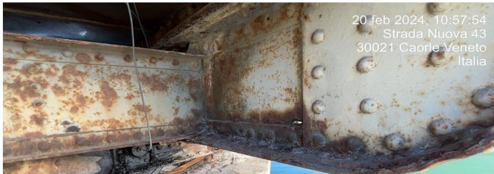
*Fig.34 Ponte di Caorle – effetti della corrosione*
