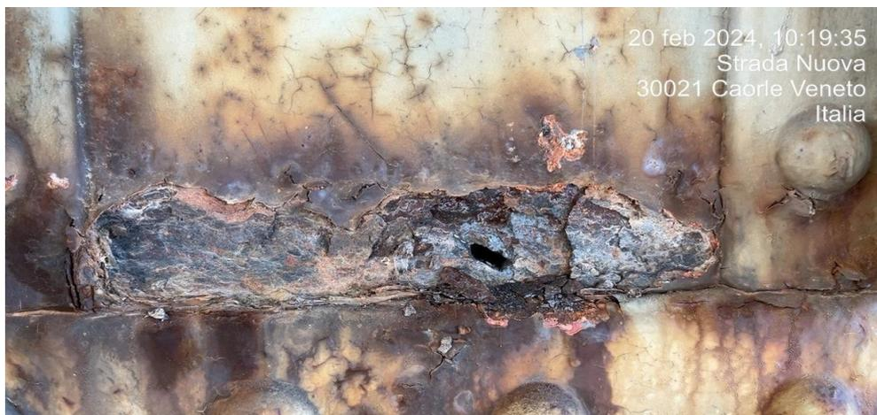
*Fig.32 Ponte di Caorle – effetti della corrosione*
