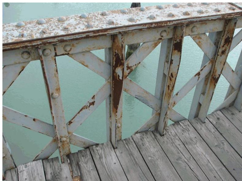
*Figura 15: Montanti con sezione deformata*
