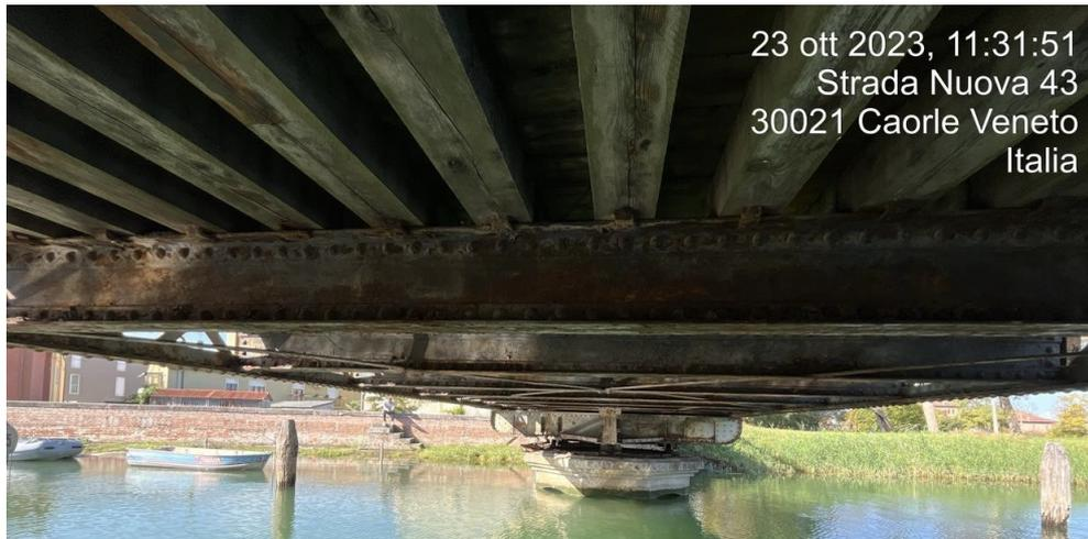
*Fig.20 Ponte di Caorle vista intradosso impalcato*
