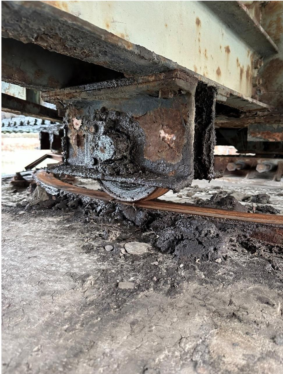
*Figura 19: Corrosione e sfogliamento diffusi all'intradosso*
