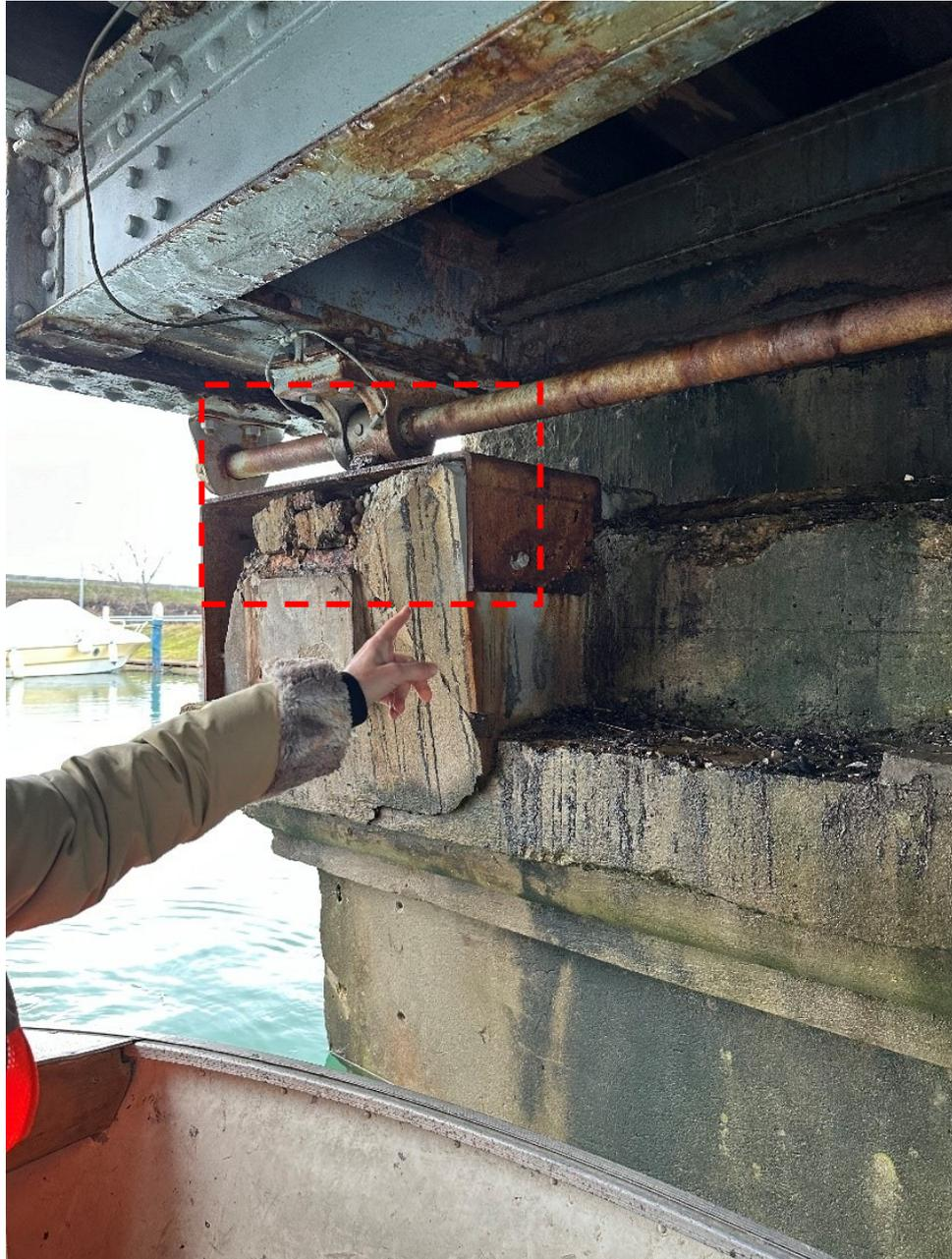
Figura 35: Baggiolo di sostegno dell'appoggio con calcestruzzo compromesso
