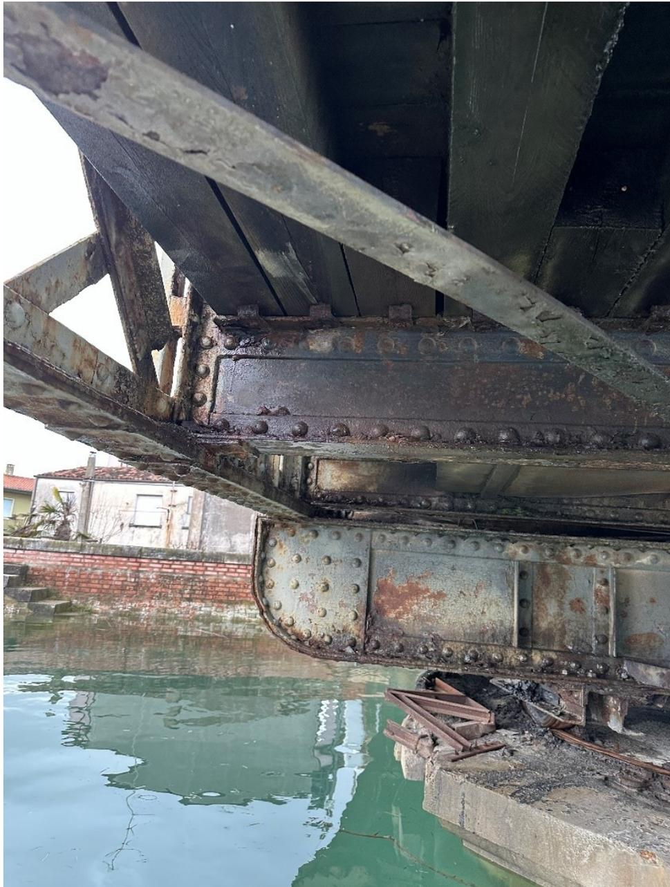
*Figura 17: Corrosione e sfogliamento diffusi all'intradosso*
