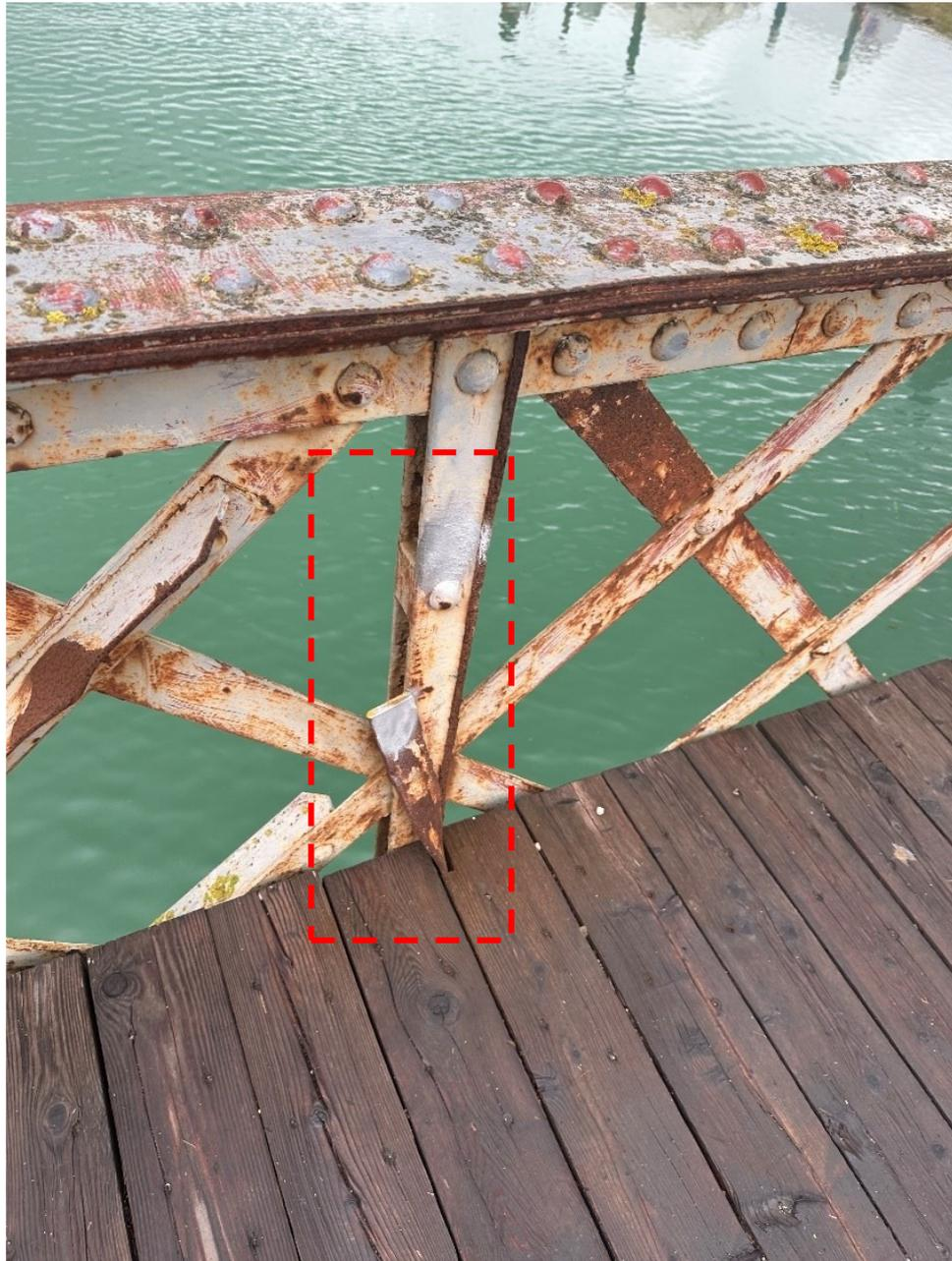
*Figura 12: Montante a L con ala completamente distaccata/mancante*
