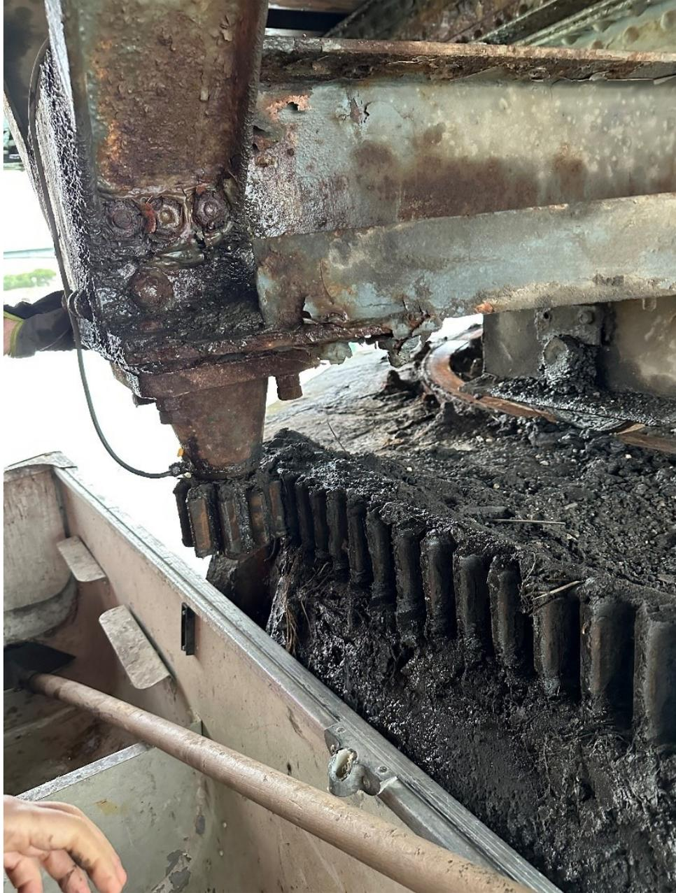
Figura 16: Corrosione e sfogliamento diffusi all'intradosso
