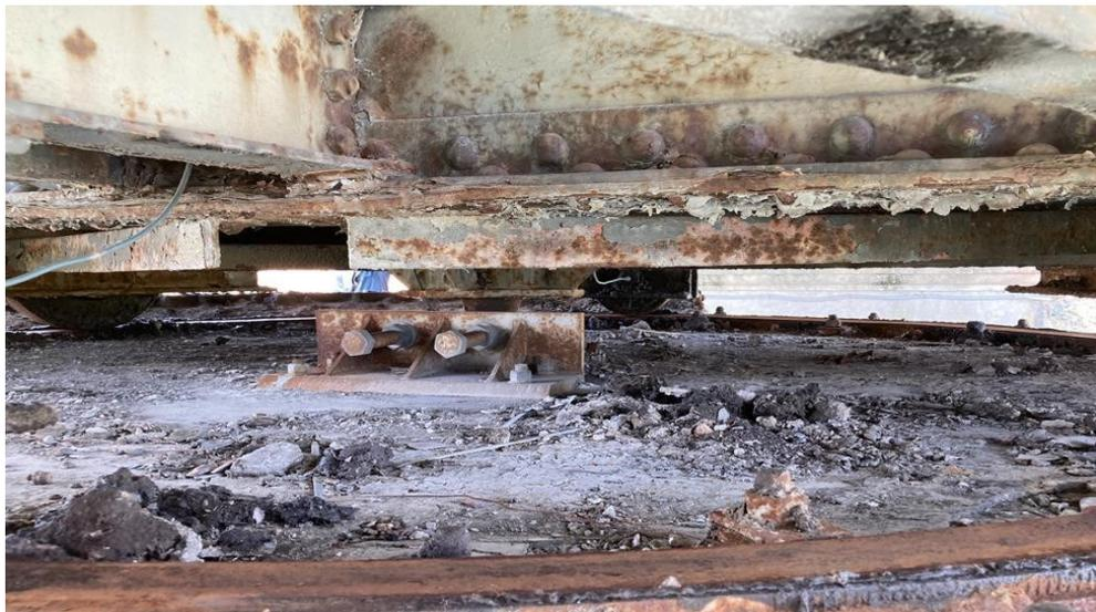
*Fig.27 Ponte di Caorle asse di centraggio – particolare supporto di contenimento spostamenti*
