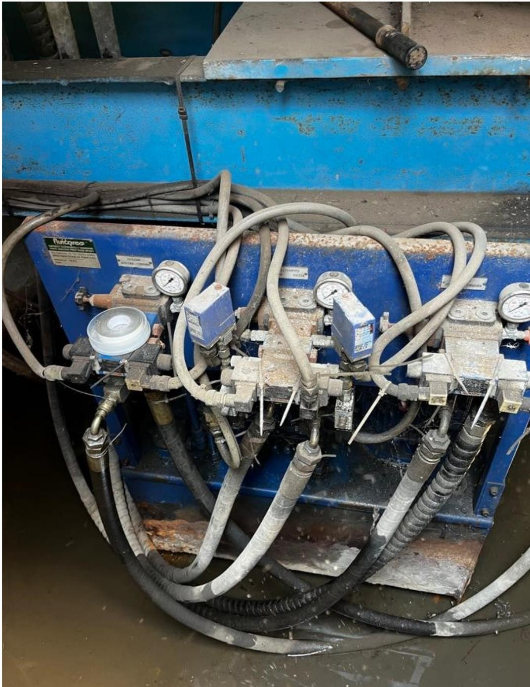
Fig.10 ponte Jesolo centralina oleodinamica
