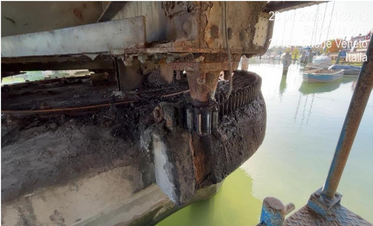
Fig.19 Ponte di Caorle meccanismo di rotazione
