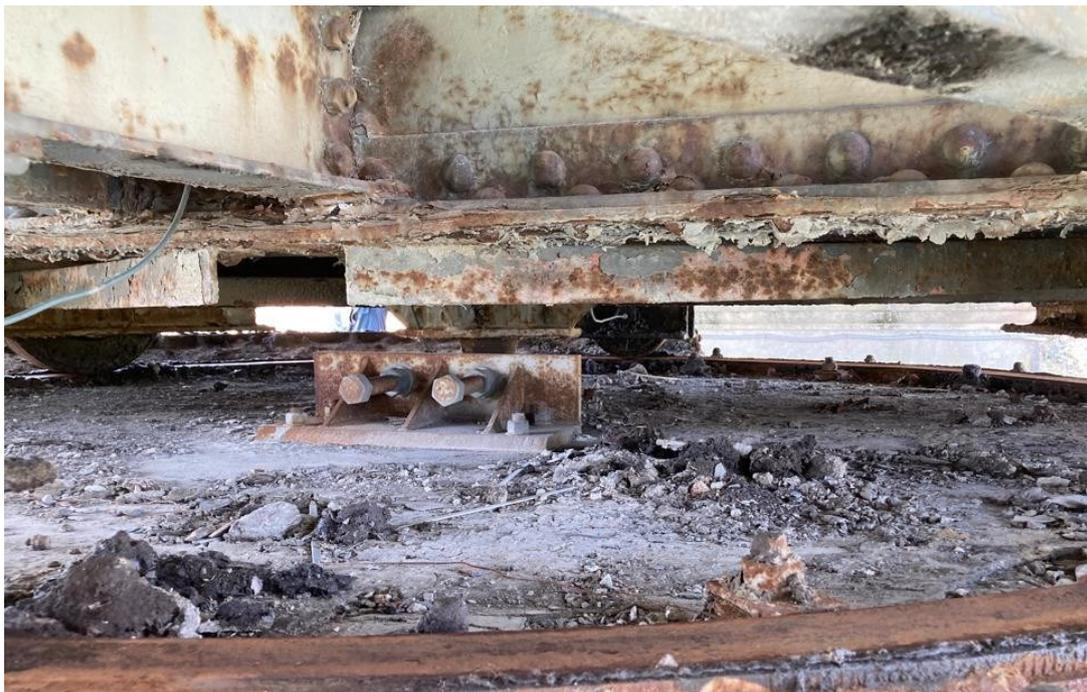
Fig.24 Ponte di Caorle asse di centraggio – particolare supporto di contenimento spostamenti
