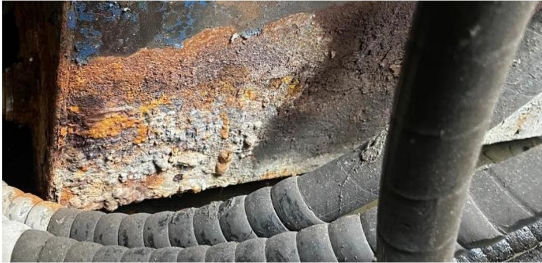
Fig.11 Ponte Jesolo centralina oleodinamica – dettaglio corrosione
