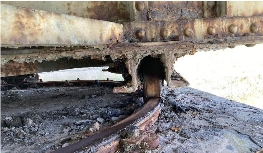
Fig.26 Ponte di Caorle gruppo rulliera – dettaglio degrado strutturale
