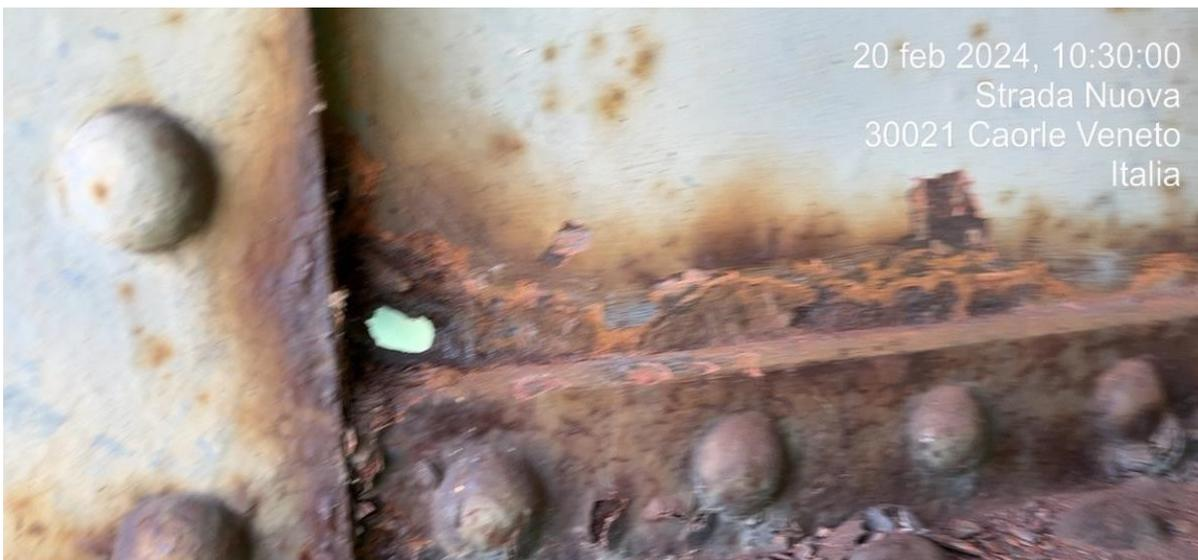
Fig.30 Ponte di Caorle – effetti della corrosione
