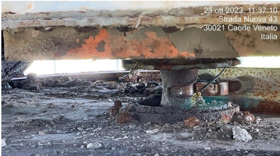
Fig.23 Ponte di Caorle asse di centraggio con incisione per usura
