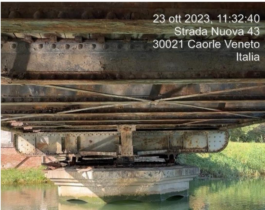
Fig.18 Ponte di Caorle vista struttura centrale di rotazione
