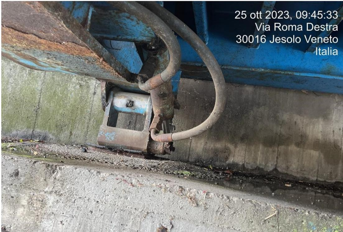
Fig.7 ponte Jesolo vista lato est – appoggio dx
