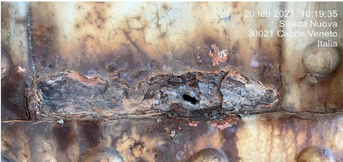
Fig.29 Ponte di Caorle – effetti della corrosione
