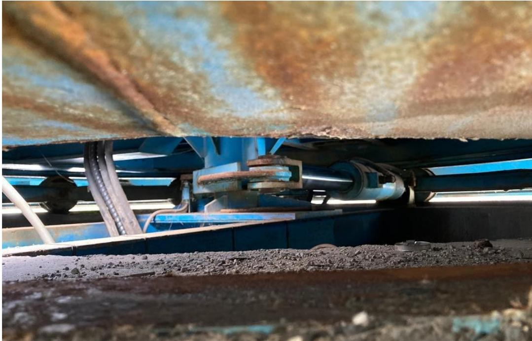
*Fig.9 ponte Jesolo cilindro oleodinamico di rotazione*
