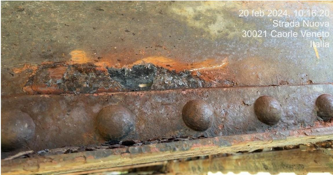
Fig.27 Ponte di Caorle – effetti della corrosione
