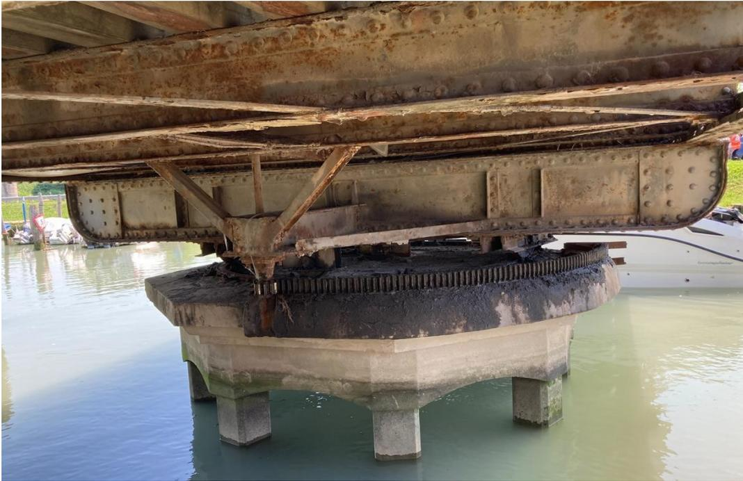
Fig.21 Ponte di Caorle meccanismo di rotazione
